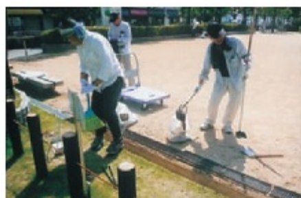
ファミリー広場と芝生広場の境にある排水溝
