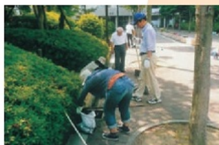
泥取り出し中の会所
