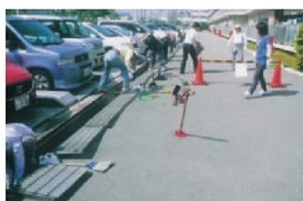
壱番館東側駐車場
